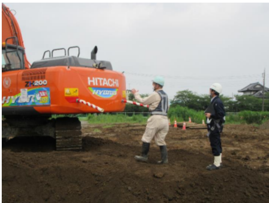
掘削作業が行われていたため、現場の担当者から重機の接触防止センサーの説明を受ける 監督安衛課長(右)
