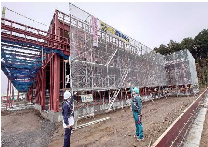
工事現場を巡視する小室署長（左）
