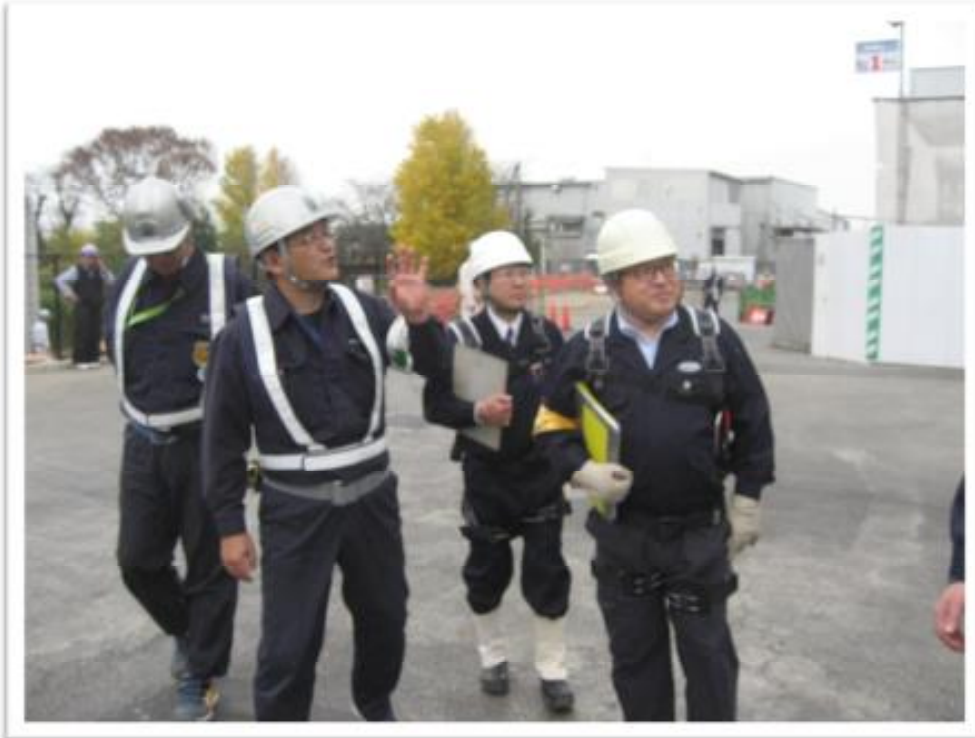
安全パトロールを行う田澤部長（右から1人目）、工藤署長（右から2人目）と工事関係者
