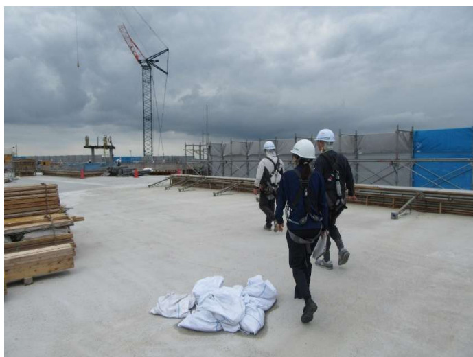
（建設現場をパトロールする署長）
