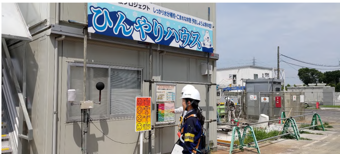
（建設現場をパトロールする署長）
