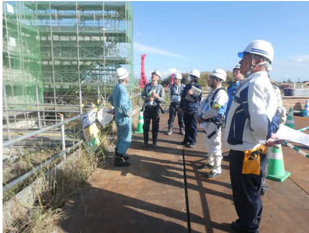
合同パトロールの様子
