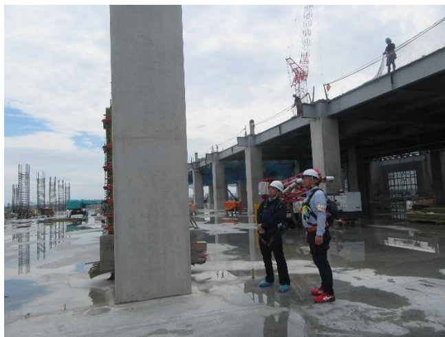
コンクリート打設後の柱の施工状況を確認する 戸田建設株式会社関東支店一瀬統括所長(右)と東海林署長
