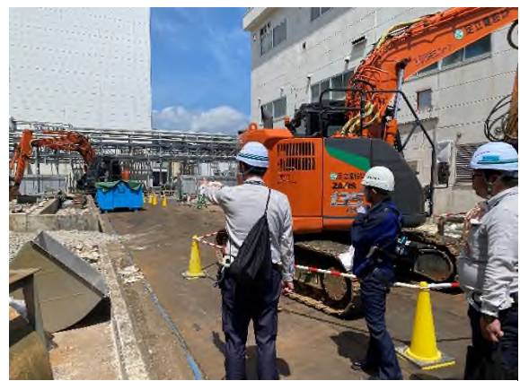
（解体工事における安全対策を確認している様子）
