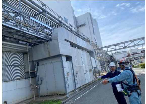
（施工箇所について確認している様子）
