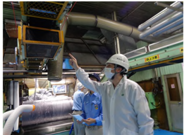
コンベアの覆いの確認をしました
