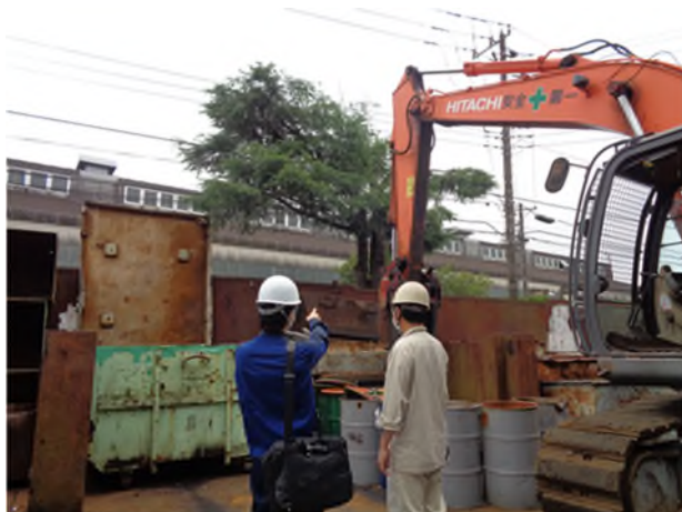
解体用つかみ機の整備状況を確認しました
