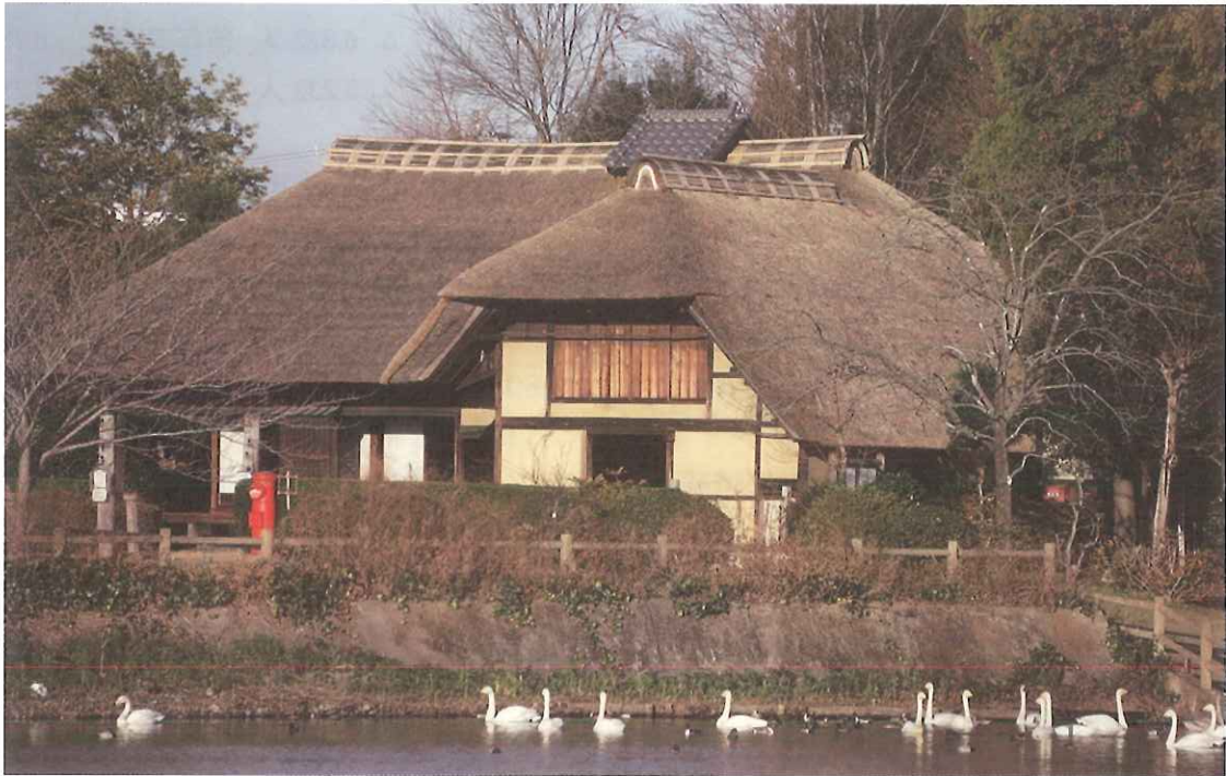
一の関ため池親水公園にある那珂市曲り屋は、文久2年（1862年）に建てられた茅葺き屋根の農家。冬には白鳥が飛来する。「那珂市曲がり屋・那珂市産業部商工観光課」
