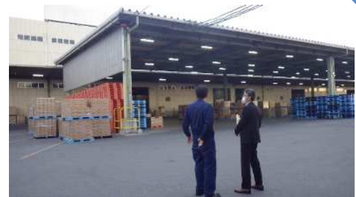
倉庫前に建設した大屋根の説明を受ける澤口局長（写真右側）
