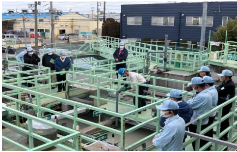
公開段取りの様子（作業風景）
