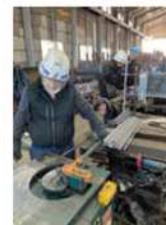
鉄筋材料の加工作業
