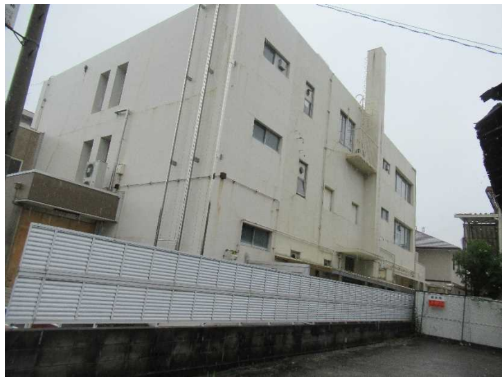
主体庁舎 庁舎北西より撮影
