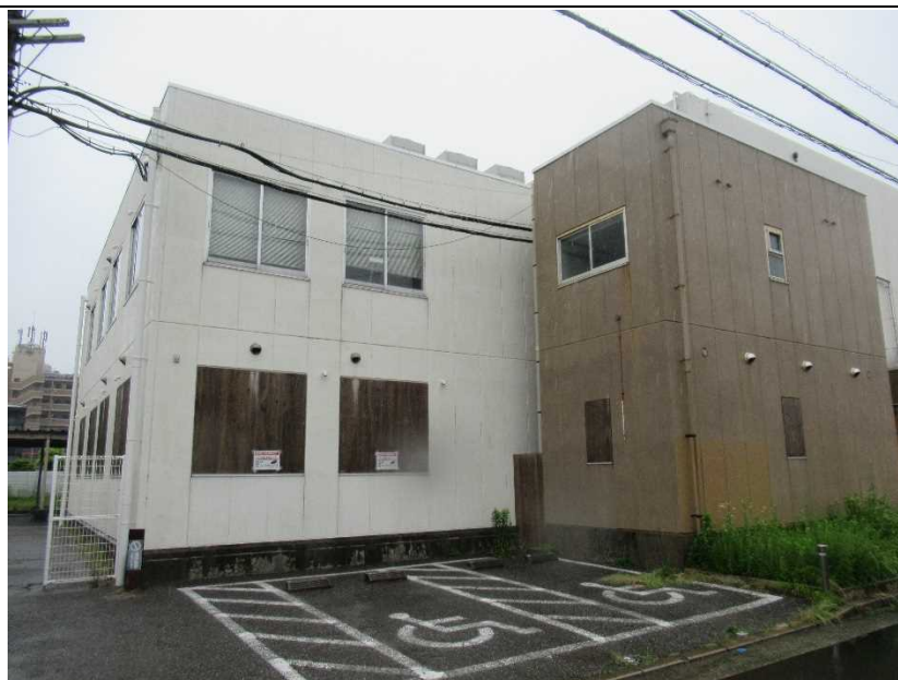
主体庁舎 庁舎北東より撮影
