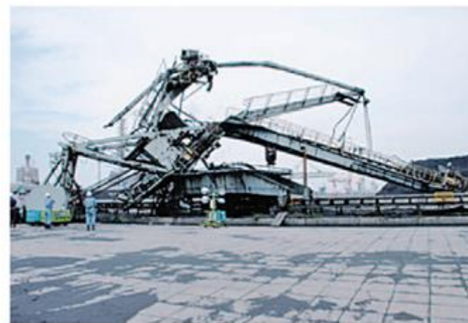
クレーンの崩落災害
