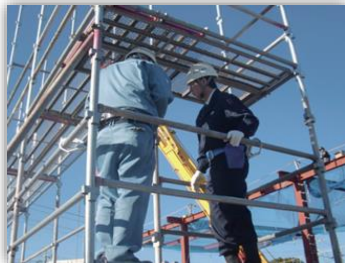
機械・設備、作業を確認
