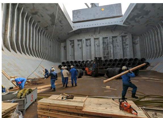
船内での荷役作業の様子
