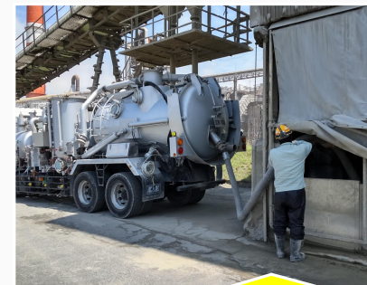
吸引車を使用して場内の各設備から発生したセメントダストの掃除
