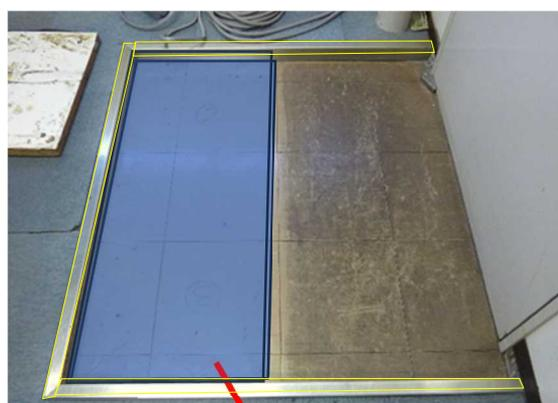
アルミ枠は残した状態で、高さを嵩上げる部材（元と同じ面積のもの）と、その上にタイルカーペットを敷設し、他のOAフロア面と同じ高さにする。
