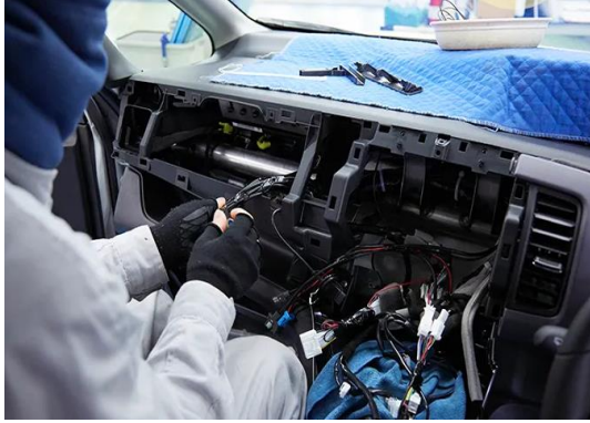
カーナビ取り付け作業
