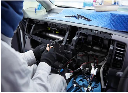
カーナビ取り付け作業
