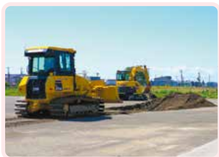
③ 建設荷役車両運転科 土間実習場
