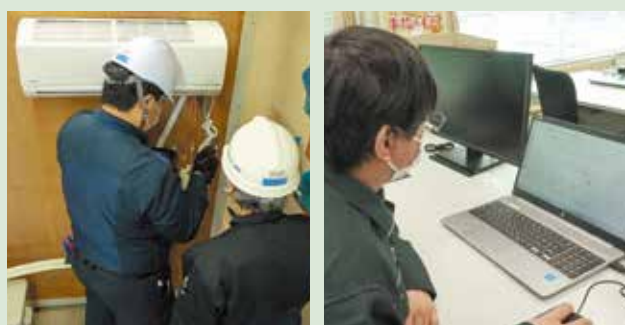
空調機器の施工、CADを用いた建築平面図及び屋内配線図作成
