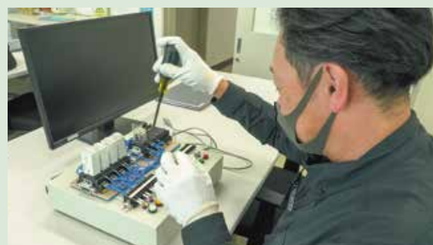
有接点シーケンス制御が含まれた設備の施工、点検
