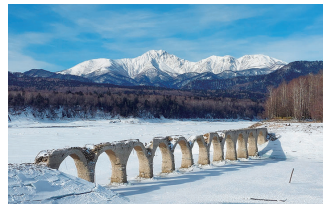
タウシュベツ川橋梁
