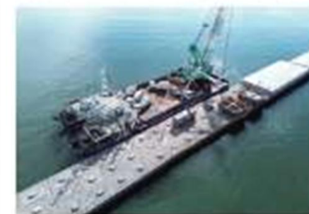
釧路港西港区 新西防波堤 上部コンクリート打設状況
