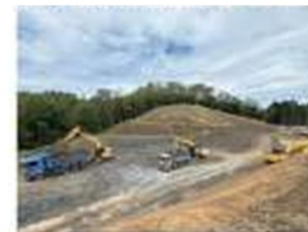
国道44号 尾幌系魚沢道路
