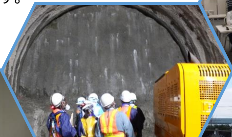
トンネル研修
