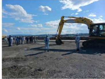
重機災害の対策 作業範囲・死角確認
