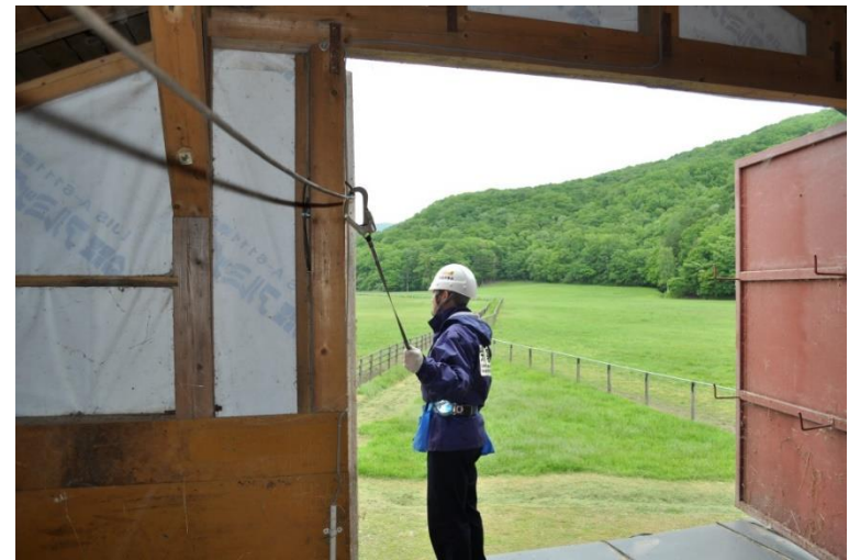
親綱、墜落制止用器具の使用例 ↑
