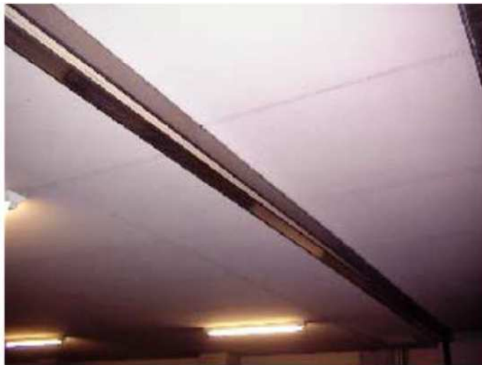
けい酸カルシウム板第1種 高比重。内装ボード、天井材などに使用。
