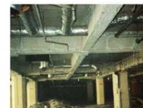
【参考】けい酸カルシウム板第2種 低比重。鉄骨の耐火被覆などに使用。
