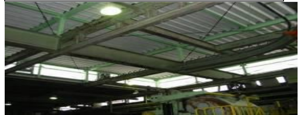
屋根用折版断熱材(フェルトン等)
