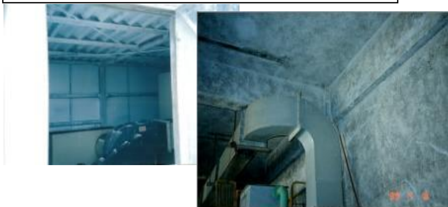
機械室の壁・天井、スラブ下・ 折版屋根の断熱、階段裏・庇裏
