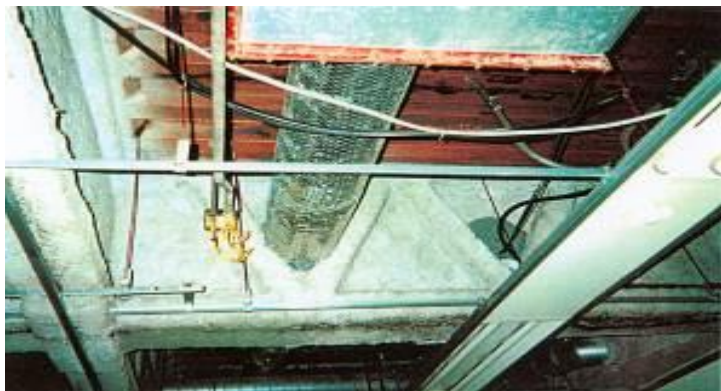
S造の梁・柱・EVS・PSの 耐火被覆
