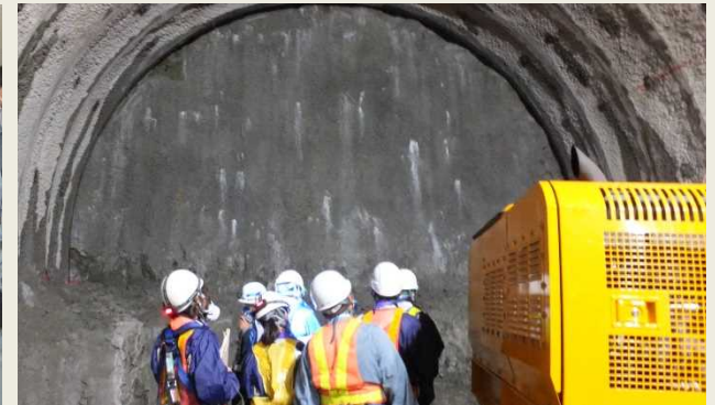
トンネル研修。切羽まで行ってトンネルの工法や安全衛生対策について研修しました。
