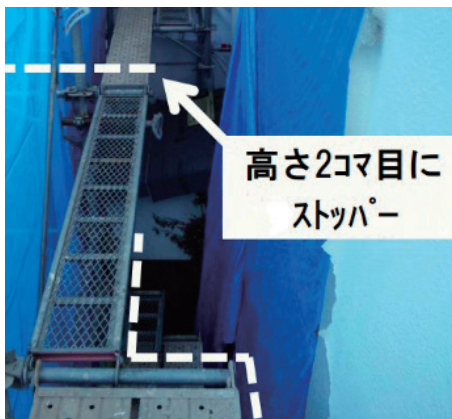
図2-17 作業床の幅が変わる箇所にはストッパーを設置
