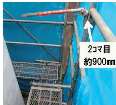
図2-18 段差のある作業床の端部にストッパーを取付けた例 (ストッパーは高い方に設置)
