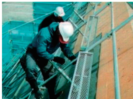
図2-6 屋根足場の例
