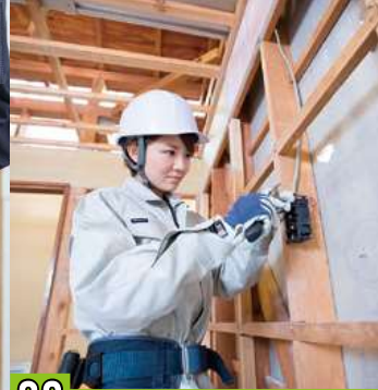
02 住宅電気工事
