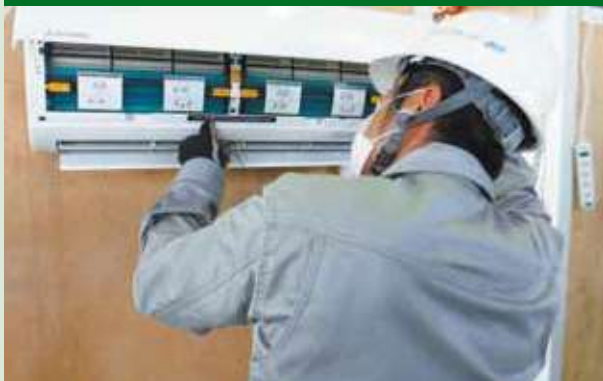
空調機器の施工、CADを用いた建築平面図及び屋内配線図作成
