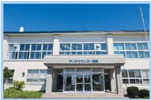
① 本館 (正面入口)
