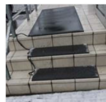
<ヒートマットの設置例>
