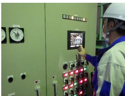
汚泥を絞る操作をしています
