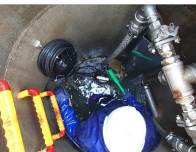
ポンプを引き上げ点検をします
