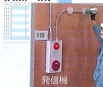
消防設備の配線工事
