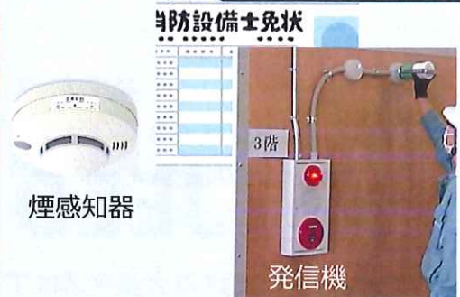
消防設備の配線工事
