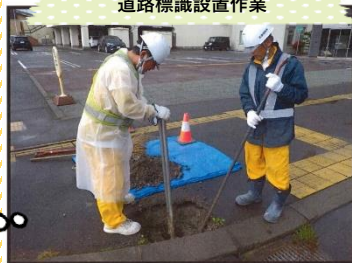
道路標識設置作業
