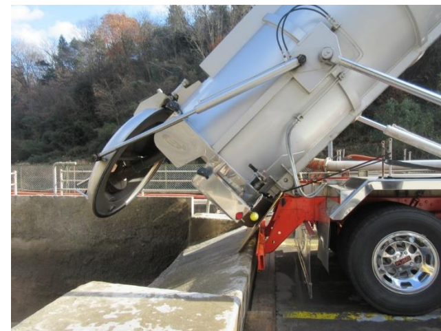
回収した汚泥をピットに移す様子
