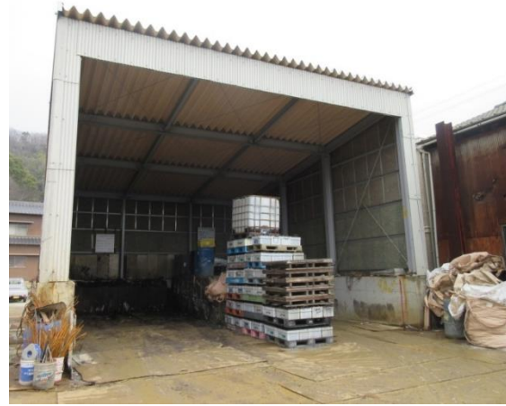
バッテリー置場
