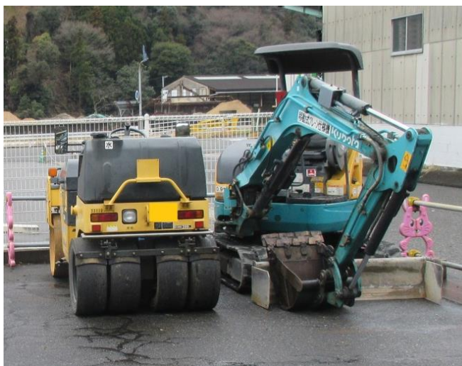
運搬する重機（例）
