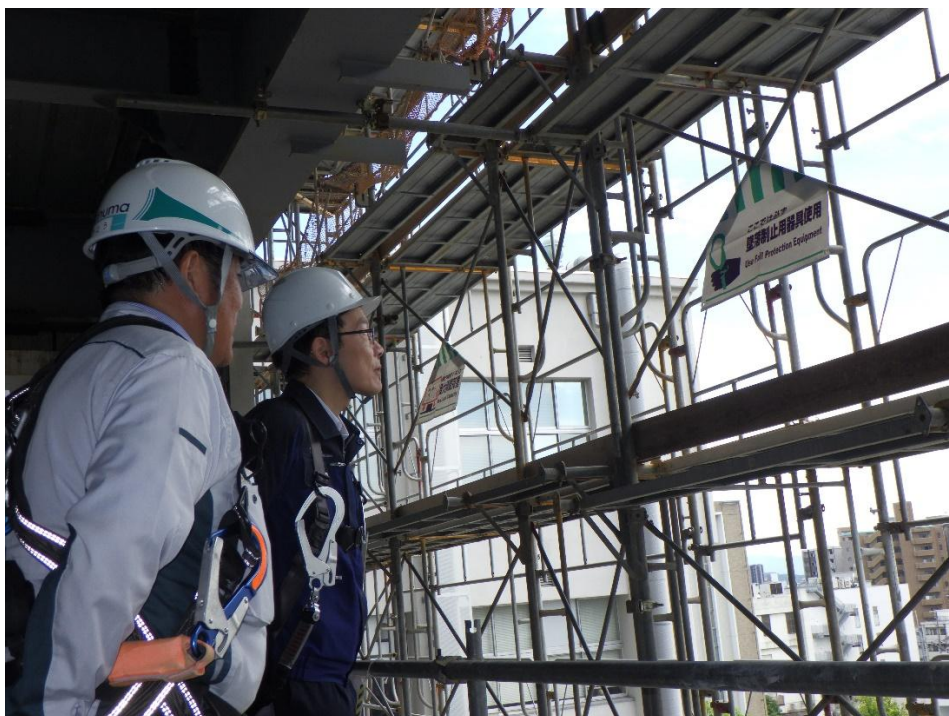
現場の安全衛生対策を確認する様子 宮原局長(左から2人目)
