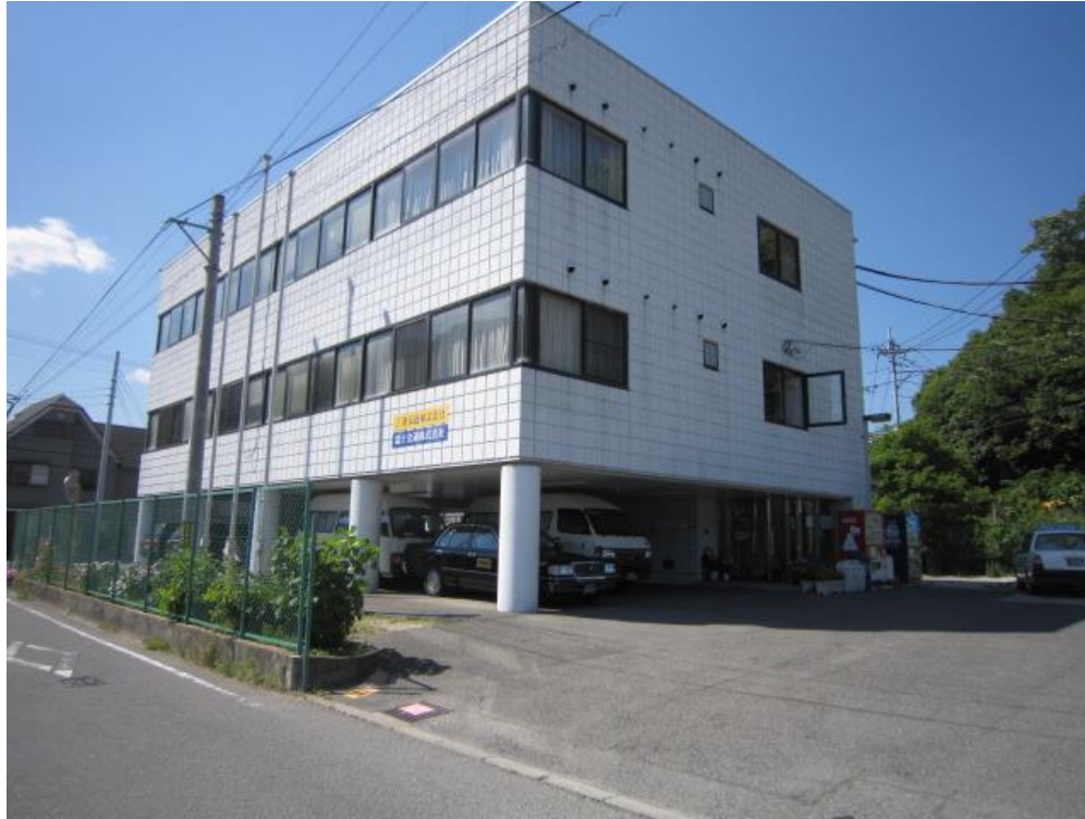
本社ビル外観
