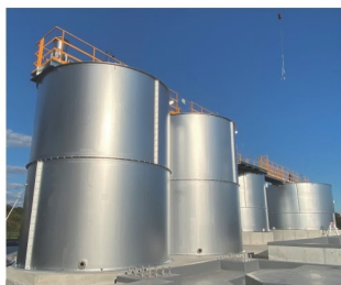
現地製缶工事（排水処理装置）
