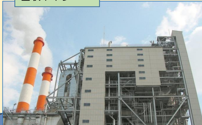
回収ボイラー
