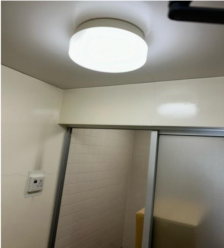
脱衣室（奥側シャワー室）
