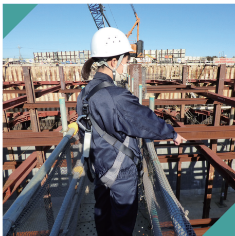
▲ 建設現場での安全確認
