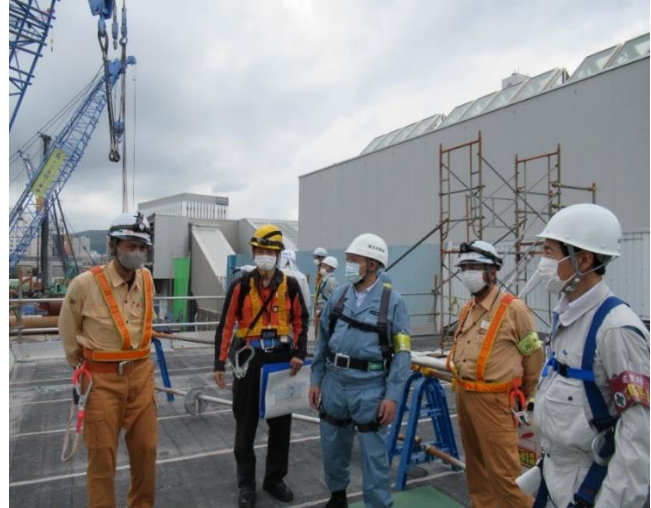
現場パトロールの様子
