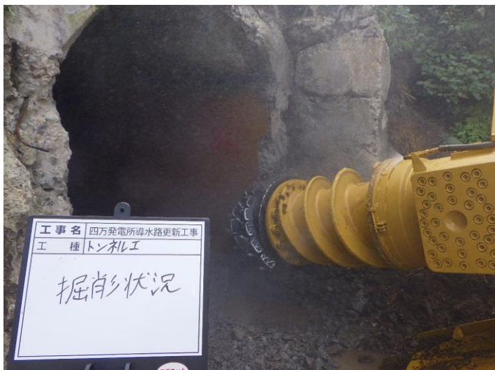
写真 自由断面掘削機により掘削している状況
