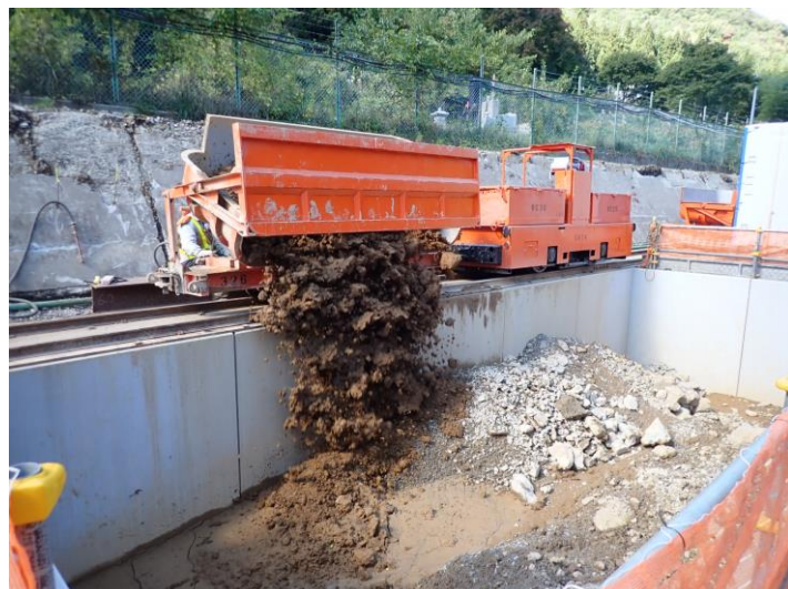
写真 鋼車からズリを排出している状況
