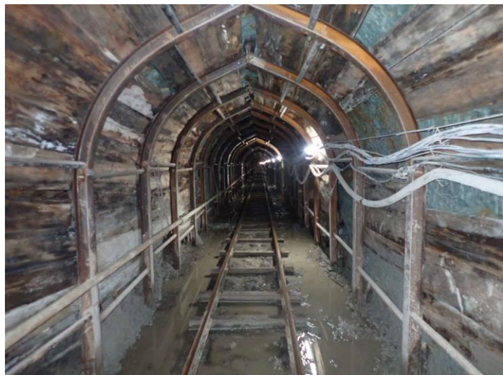
写真 工事中の四万発電所導水路トンネル内の写真
