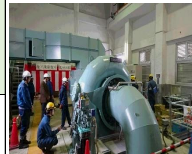
【作業風景】 試験工程
